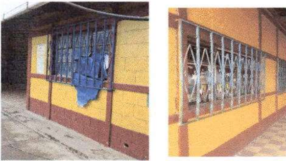
Foto 3: Mantenimiento de balcones de metal.
