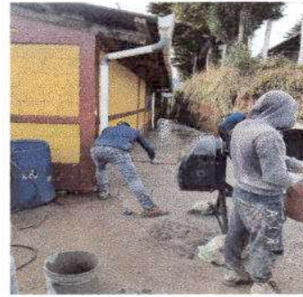
Foto 4: Reparación de piso de torta de concreto
