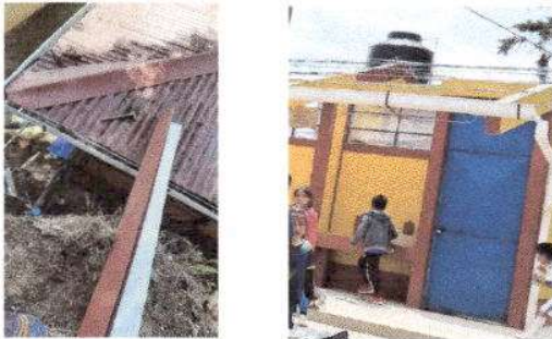
Foto 5: Sustitución de canal de pvc
